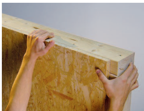
Assemblage d'ossature bois
