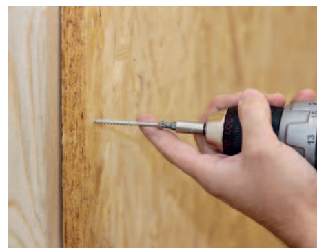
Fixation de panneaux sur ossature bois
