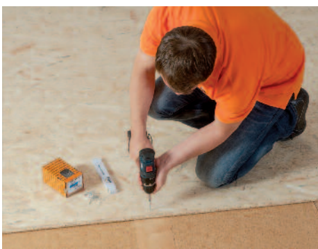
Travaux de pose
