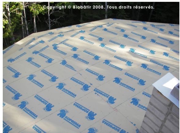
Première membrane (sous-couche) appliquée minutieusement
