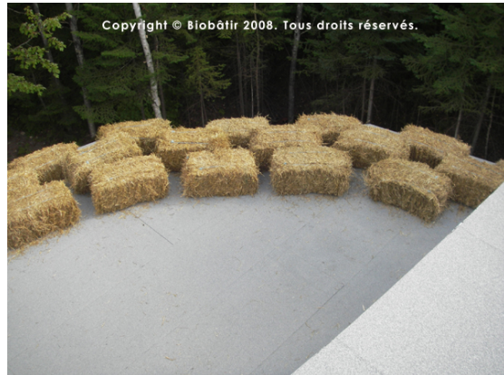
Les ballots de paille sont placés de cette façon et détachés par la suite
