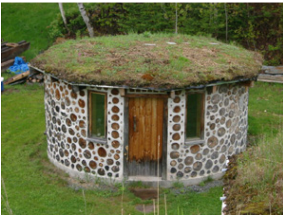
Toit végétal à Earthwood Building School
