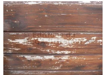
Fig.38: Douglas lasuré, quelques temps après la mise en œuvre.
