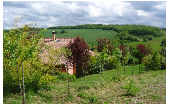
Fig.75: Vue sur la maison depuis la route
