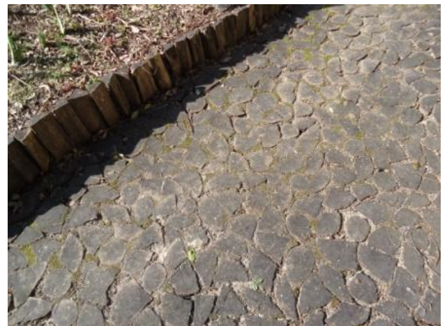
Fig.52: Traitement de sol
