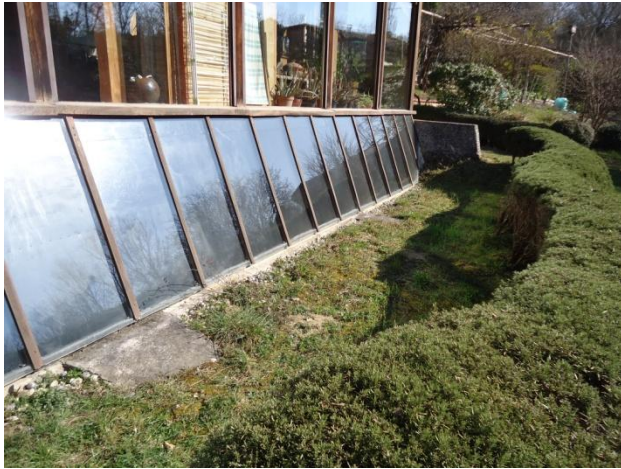
Fig.49: Haie végétale courant le long des capteurs solaires
