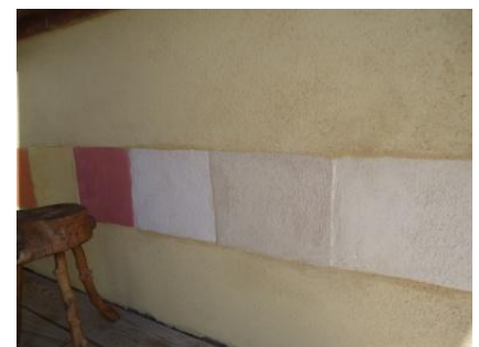
Fig.79: Bande d'essai couleurs d'enduit sur la façade Ouest
