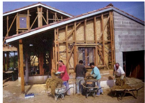
Fig.74: La maison pendant le chantier
