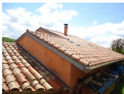
Fig.78: Vue sur la façade enterrée Nord
