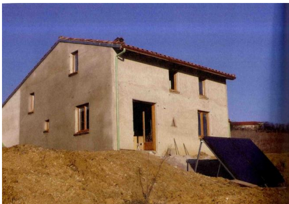
Fig.73: La maison pendant le chantier
