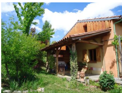
Fig.77: Vue sur la façade Ouest
