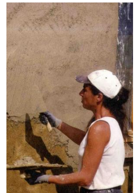
Fig.72: Application de l'enduit terre
